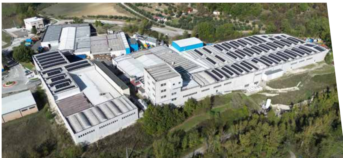
Installazione pannelli fotovoltaici presso Tratos HV
