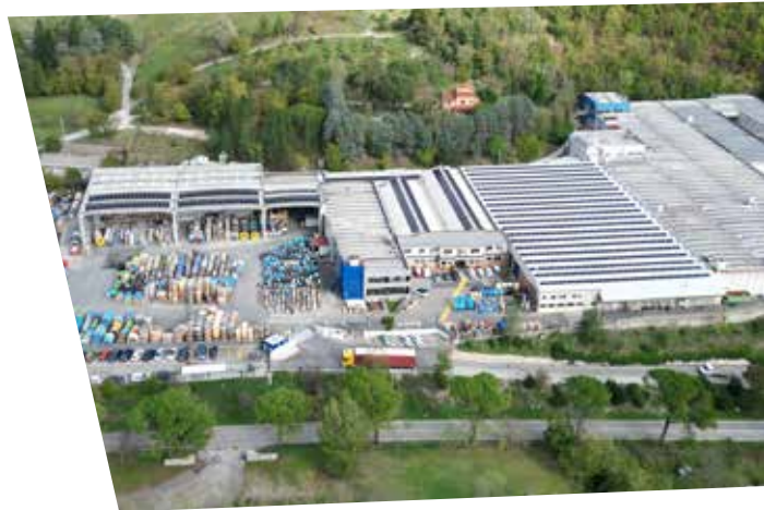
Parco di pannelli fotovoltaici presso lo stabilimento di Tratos Cavi Pieve Santo Stefano
