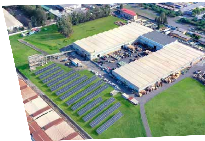
Parco di pannelli fotovoltaici presso lo stabilimento di Tratos Cavi Catania
